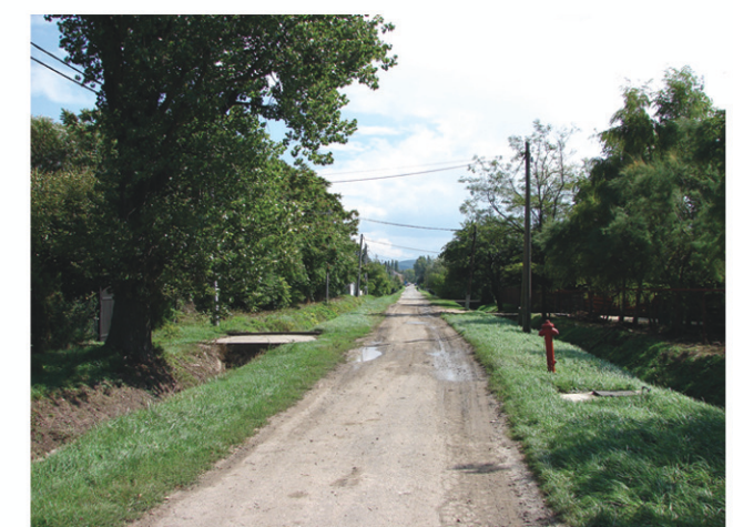
Nem megfelelő lejtésviszonyok, vízelvezetési problémák
