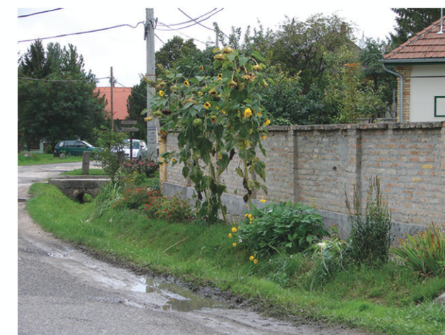
Nem megfelelő lejtésviszonyok, vízelvezetési problémák
